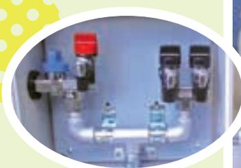
写真③ 緊急時供給弁
