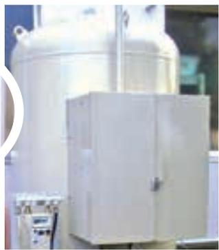
写真② タンク式LPガスボンベ
